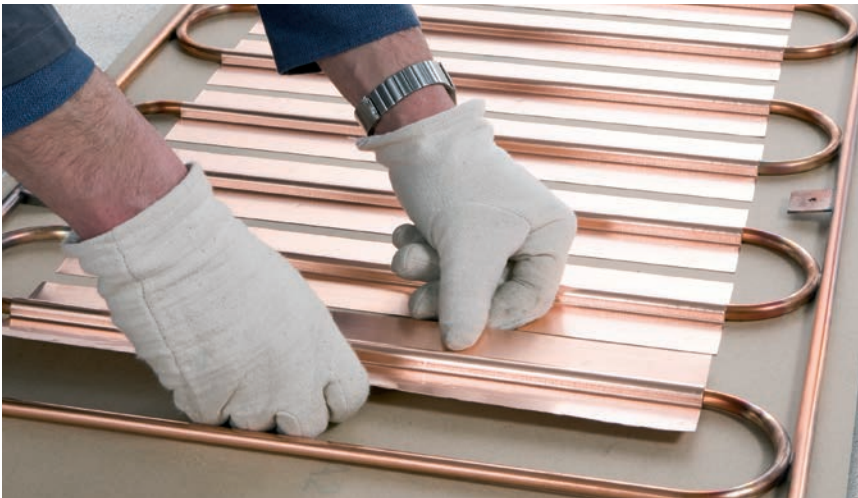
Σχήμα 1: προσχηματισμένα χάλκινα πηνία προσαρτημένα σε γυψοσανίδες
